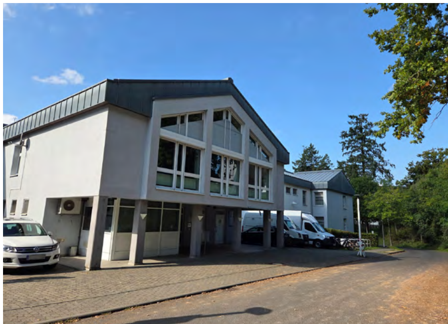
Das Haus G7 neu (links) ist das einzige für die forensische Psychiatrie neu gebaute Haus, eröffnet 1997. Hier erfolgt die hochgesicherte Unterbringung. Alle anderen von der forensischen Psychiatrie genutzten Gebäude gehören der Vitos Gießen-Marburg, so wie das hier gezeigte Haus 4 (unten). Die Sicherung ist hier geringer.
